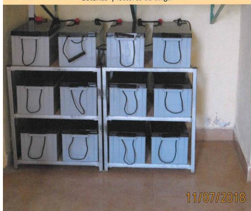
Baterías y lectores de carga.
